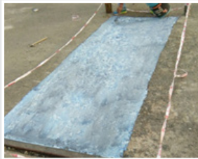
Concrete floor repair primer
